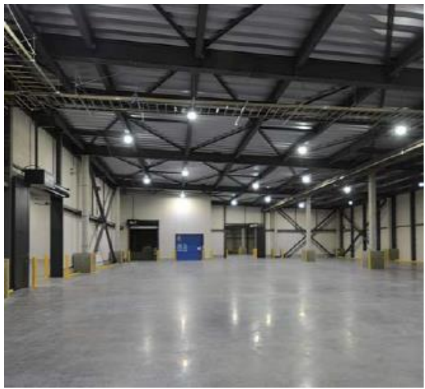
定温/定湿倉庫
