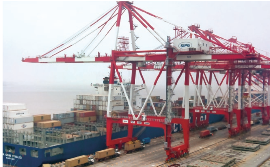
上海洋山深水港コンテナターミナル
