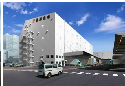
名古屋営業所 A号倉庫
