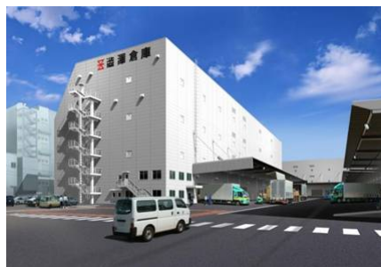
名古屋営業所 A号倉庫
