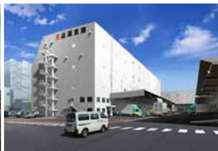
名古屋営業所 A号倉庫
