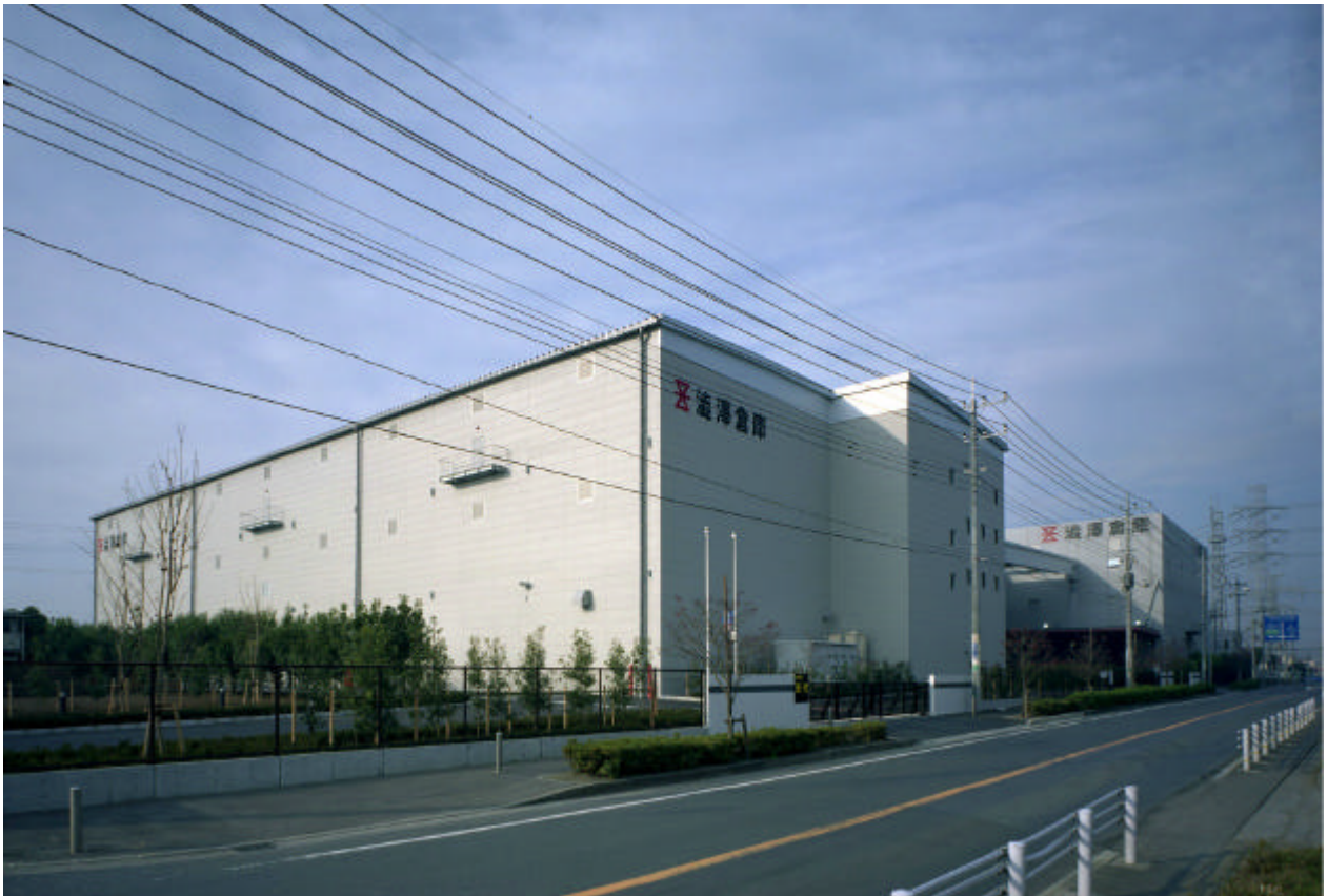
北東側からの景観 (新設第二倉庫は手前側)
