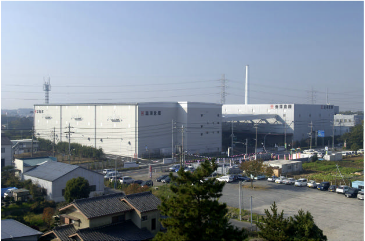
北東側からの景観 (新設第二倉庫は左側)
