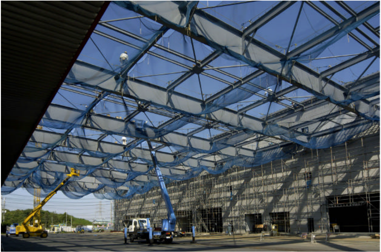
大庇鉄筋（工事中）
