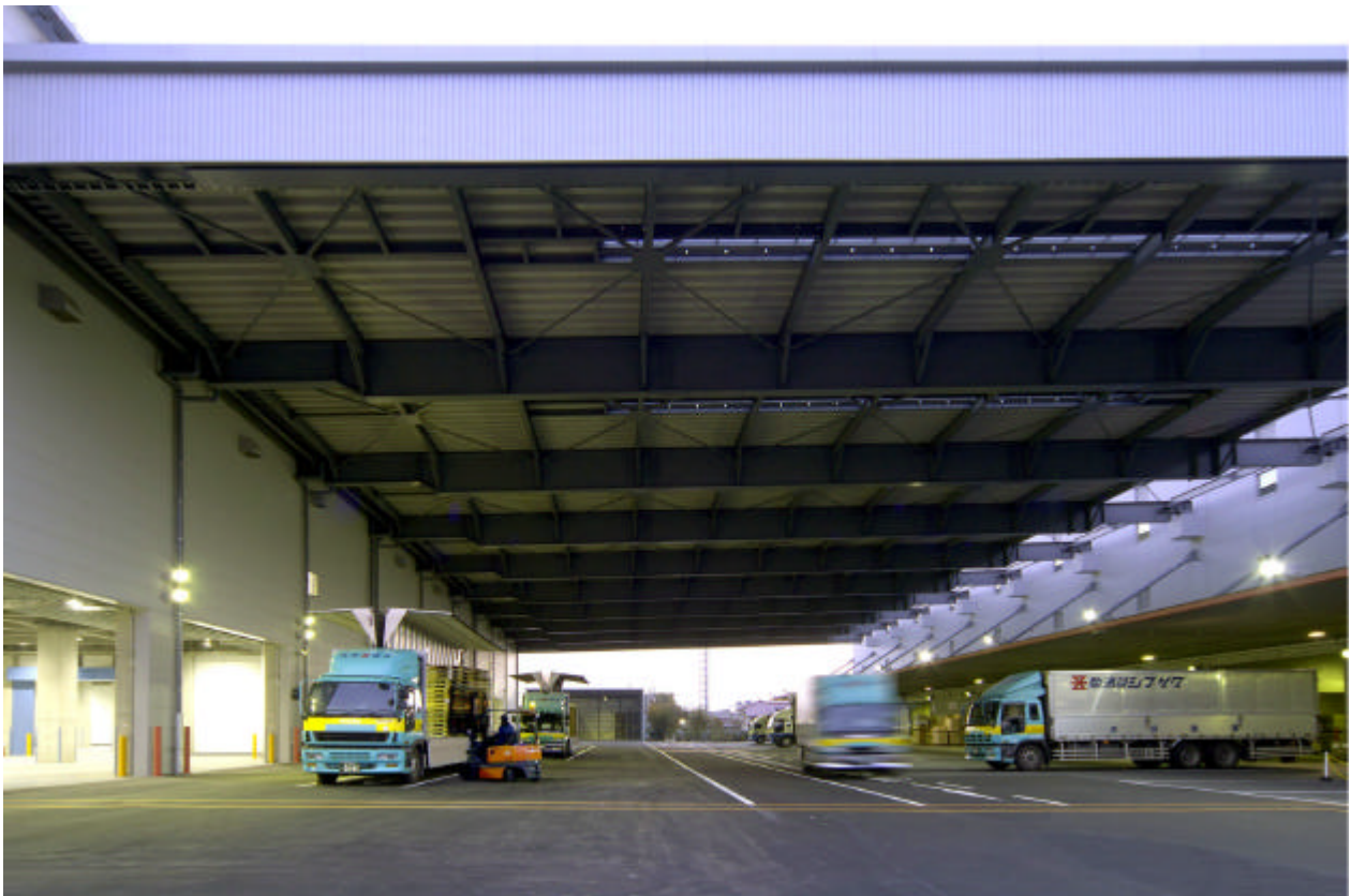
大庇の下 (荷捌エリア)
