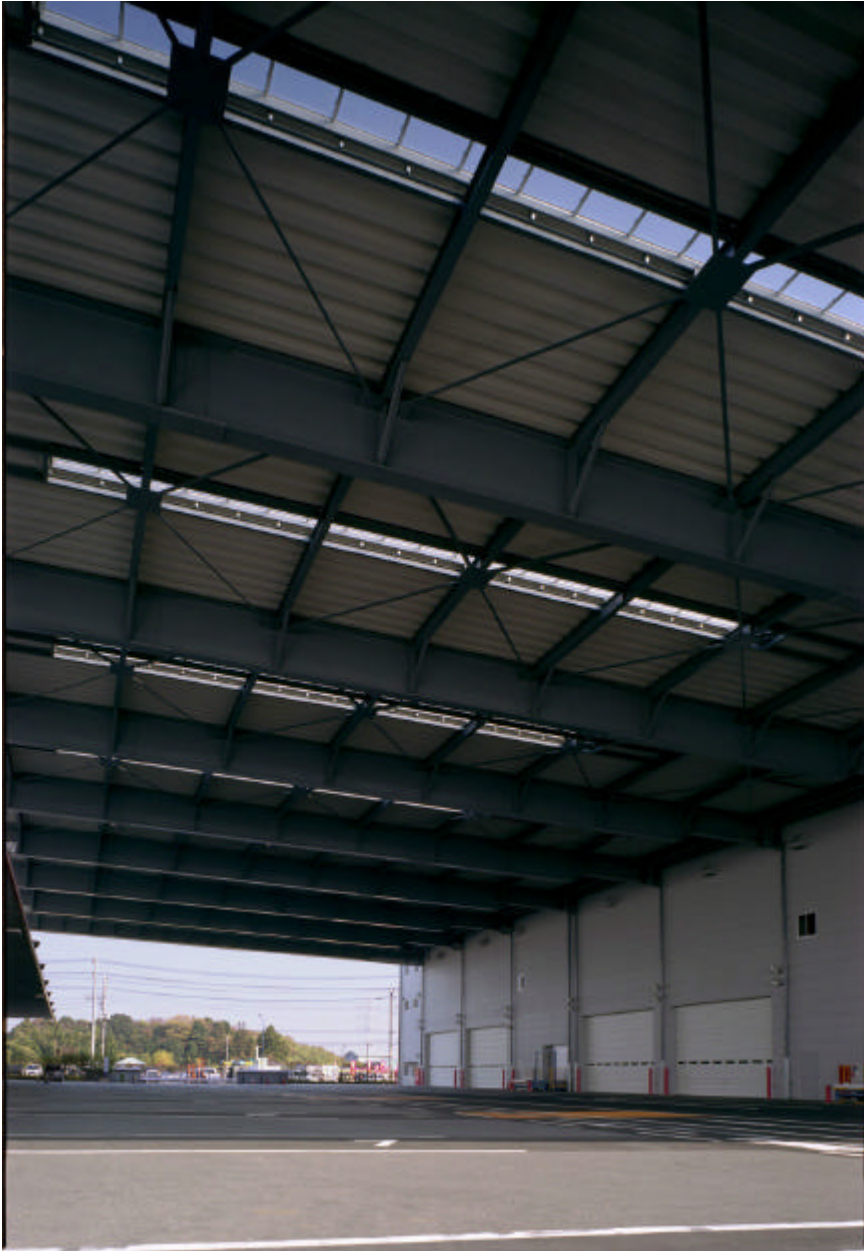
大庇 南西側からの景観
