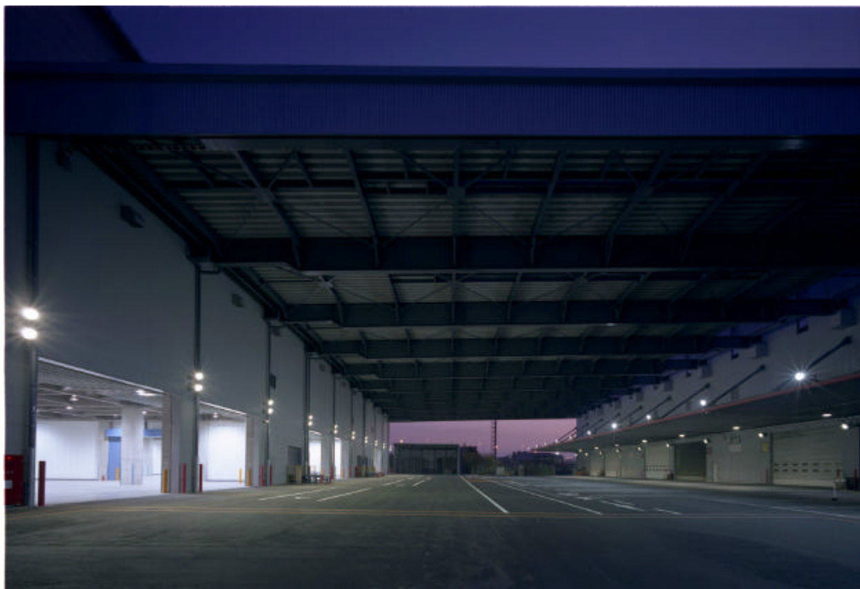
荷捌エリア北側（夜景）
