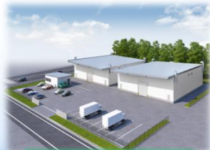
2025年4月稼働予定 栃木 危険物倉庫
