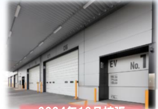
2024年10月拡張 松戸 第3倉庫
