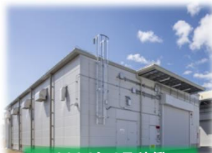
2024年4月稼働 神戸 危険物倉庫
