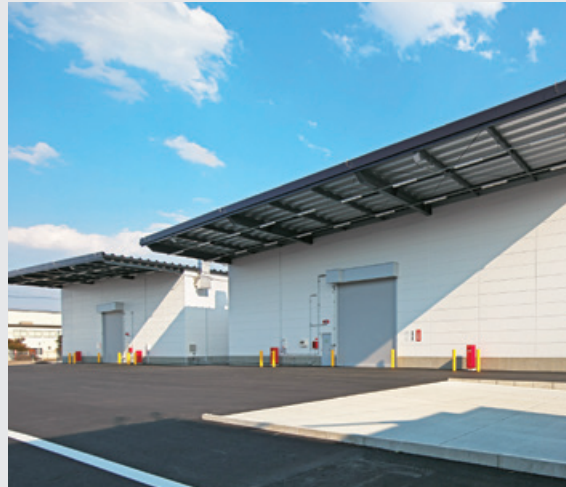
栃木営業所 危険品倉庫
