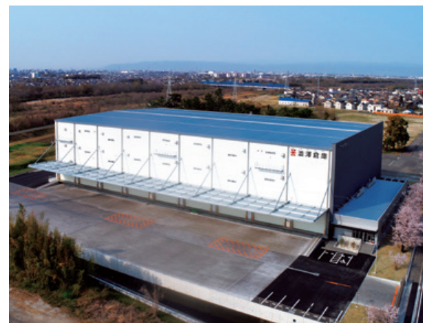
名古屋営業所 岐阜倉庫全景
