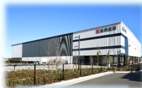
千葉北 第3倉庫
